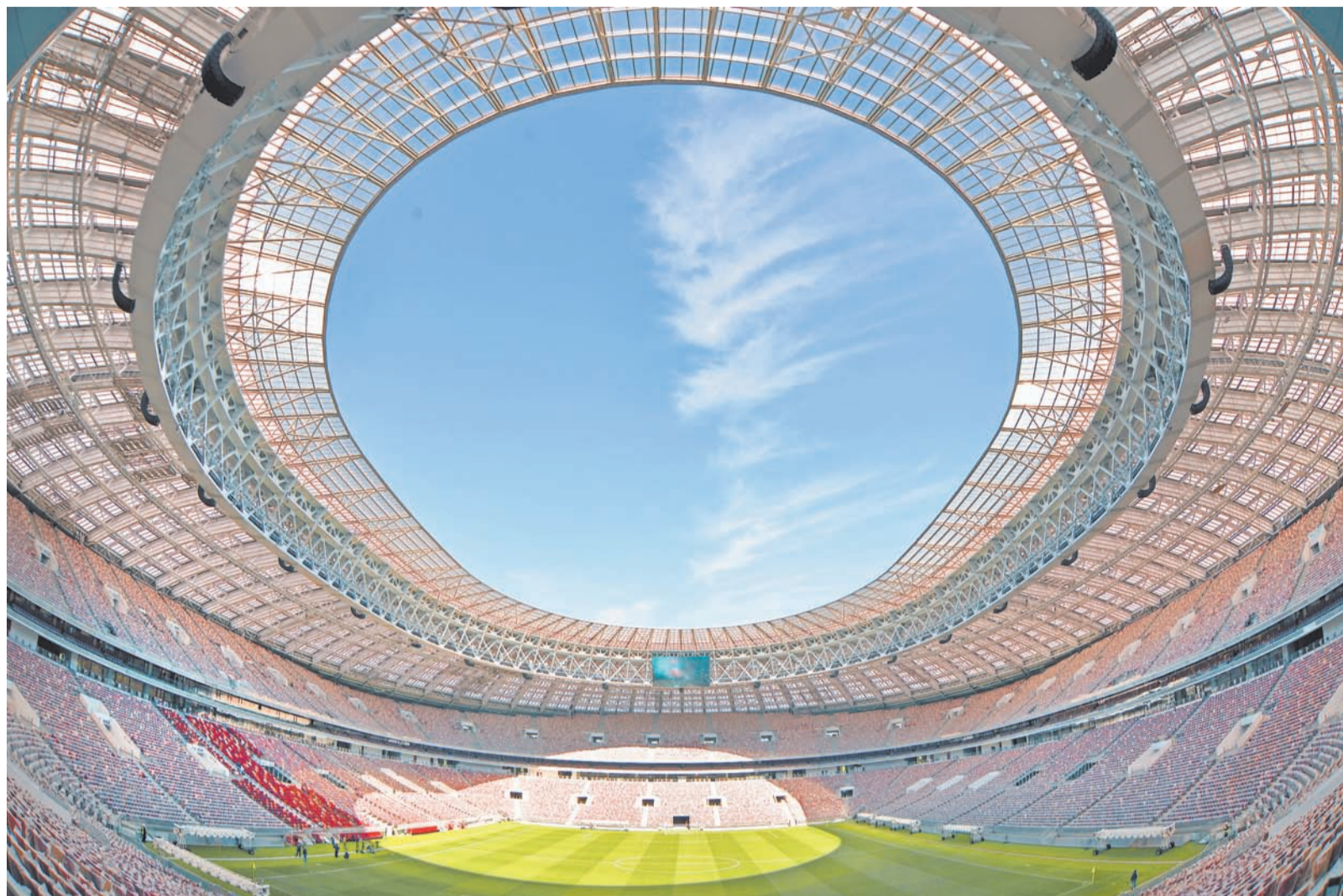
Кровлю Большой спортивной арены с помощью светодиодов превратили в полноценный медиаэкран площадью 40 тыс. кв. м. Два табло (на южной и северной трибунах) будут транслировать статистику и интересные моменты матчей.
