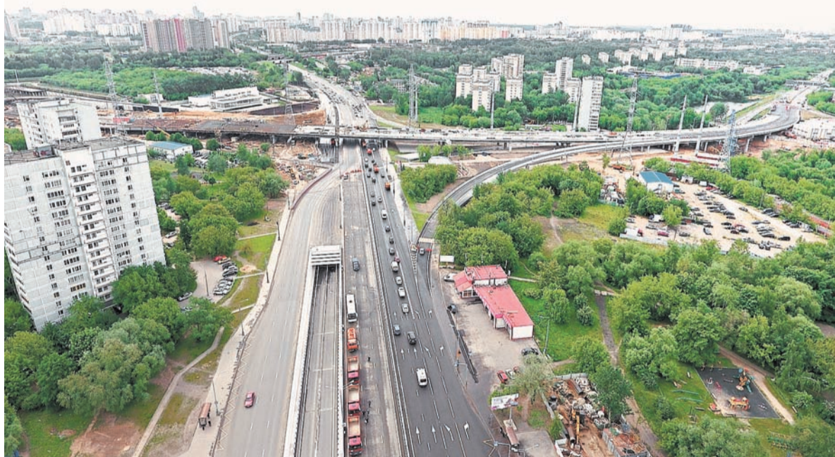
На Аминьевском шоссе построили две эстакады, два тоннеля, два моста через реку Сетунь. А всего 8 км новых дорог.
