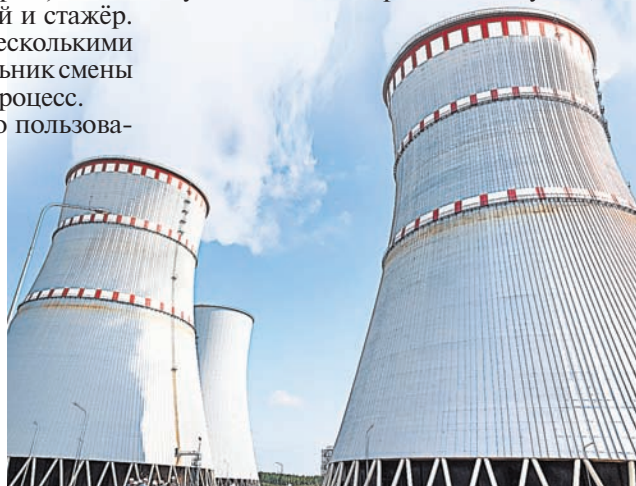
Градирни – сложные и при этом очень красивые инженерные объекты станции.
