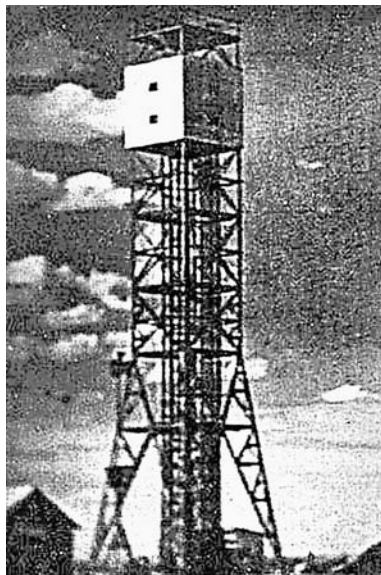
Башня, на которой был размещён заряд первой отечественной атомной бомбы РДС-1, 1949 г.
