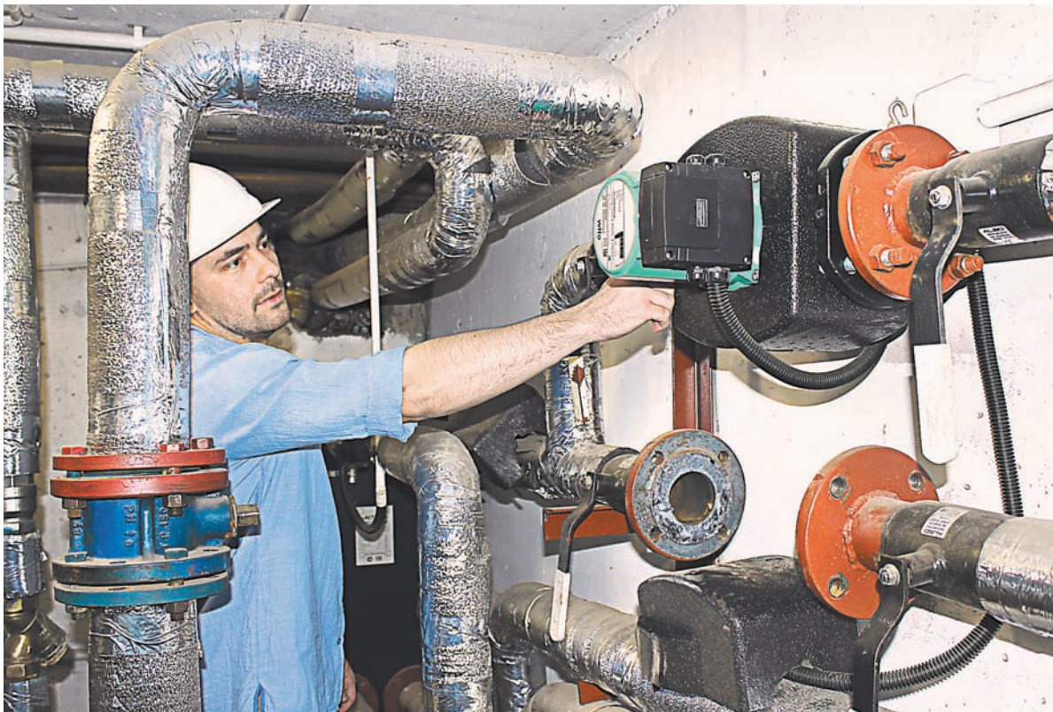
В подвале дома 8 по ул. Карбышева в Калининграде, где провели энергоэффективный капремонт.
