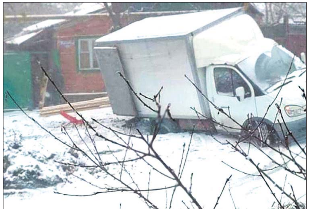
После сооружения новых очистных в поселке Южном в дорогах появились опасные ямы
