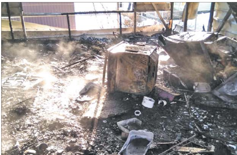
Из-за короткого замыкания сгорел дотла частный дом.
