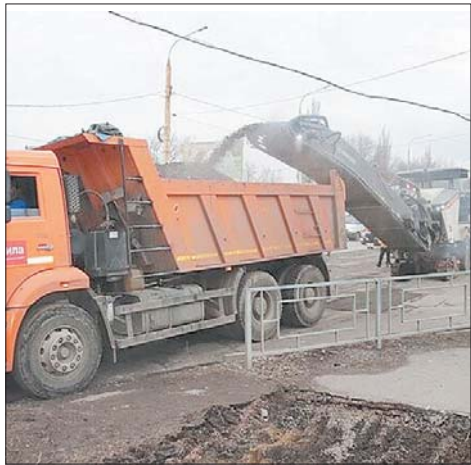
Ремонт дороги на Победе Революции продлится до августа.
