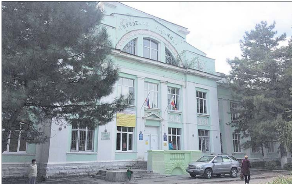
Здание поликлиники было построено первым.
