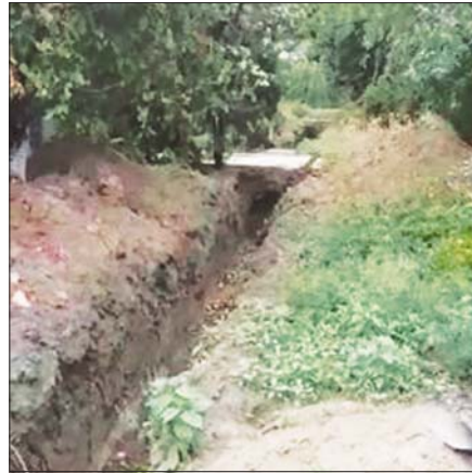
Замену трубы жители Майского ждали больше года.
