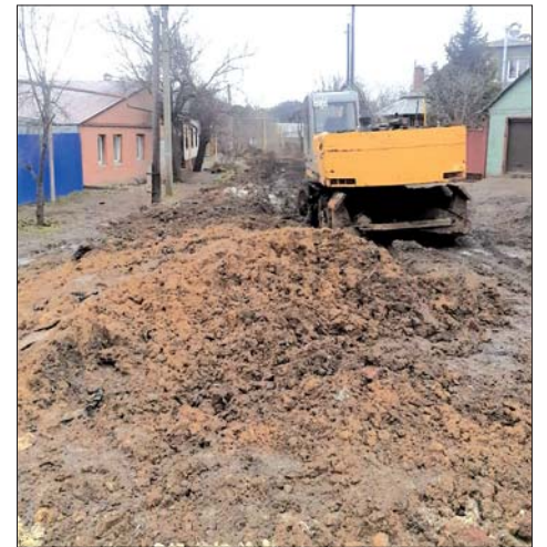
Жители переулка Демёхина недовольны разрытой дорогой после ремонта труб.
