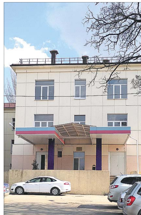
Здание травматологии отремонтировали 9 назад.
