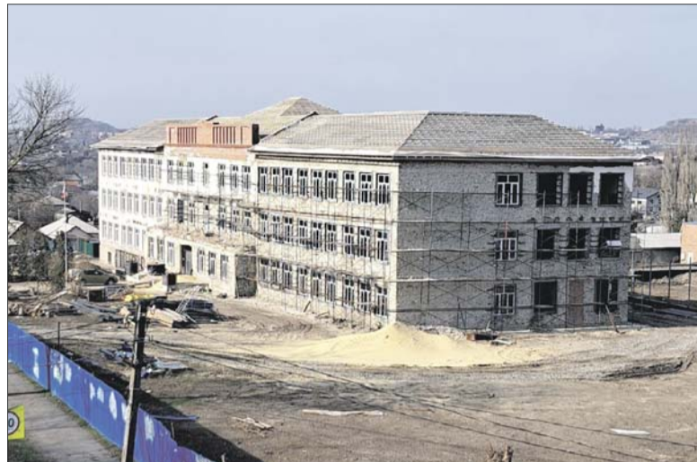
Капитальный ремонт школы затянется до 2028 года.
