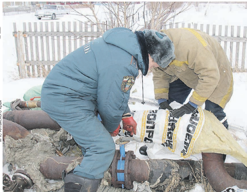
Сейчас в селе экстренно прокладывают новые трубы.
