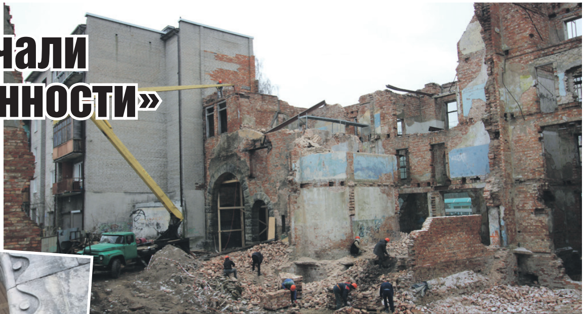
По словам подрядчика, пока проводятся только противоаварийные работы.
