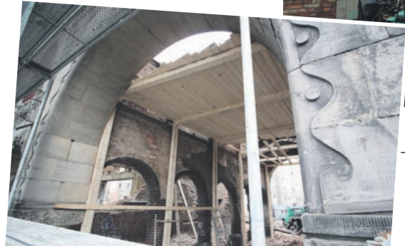
В знаменитой арке видны временные деревянные перекрытия.
