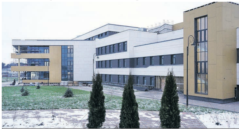
В строящемся центре проводится много внутренней работы.
