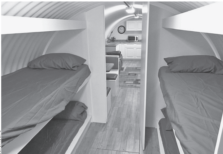
Этот вариант типа купе - бюджетный, сделанный в металлической трубе диаметром метра 3 - 4, вкопанной в землю на глубине метра-двух, с минимумом удобств.
