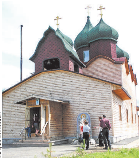
В Яе эта церковь была единственной на всю округу.
