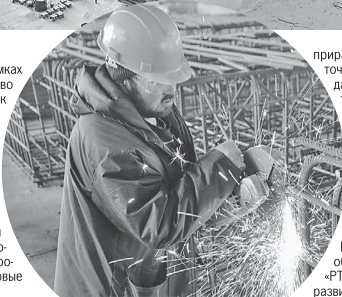
Монтаж оборудования на высокотехнологичном предприятии - дело тонкое.
