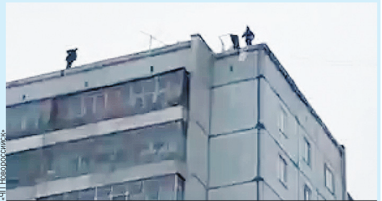
Очевидцы засняли, как с крыши сбрасывают куски металла.
