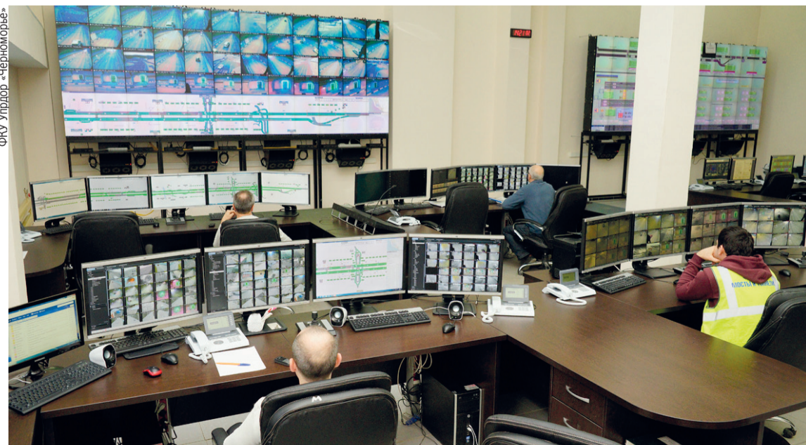
Центр управления производством (ЦУП) Дублера Курортного проспекта, Сочи.
