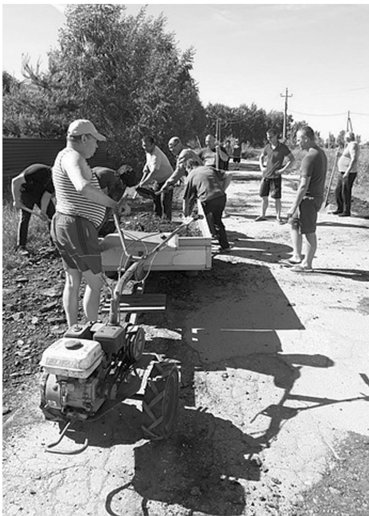
Обошлись без катков, битума и прочих излишеств - в ход пошли тачки, лопаты и асфальтовая крошка.
