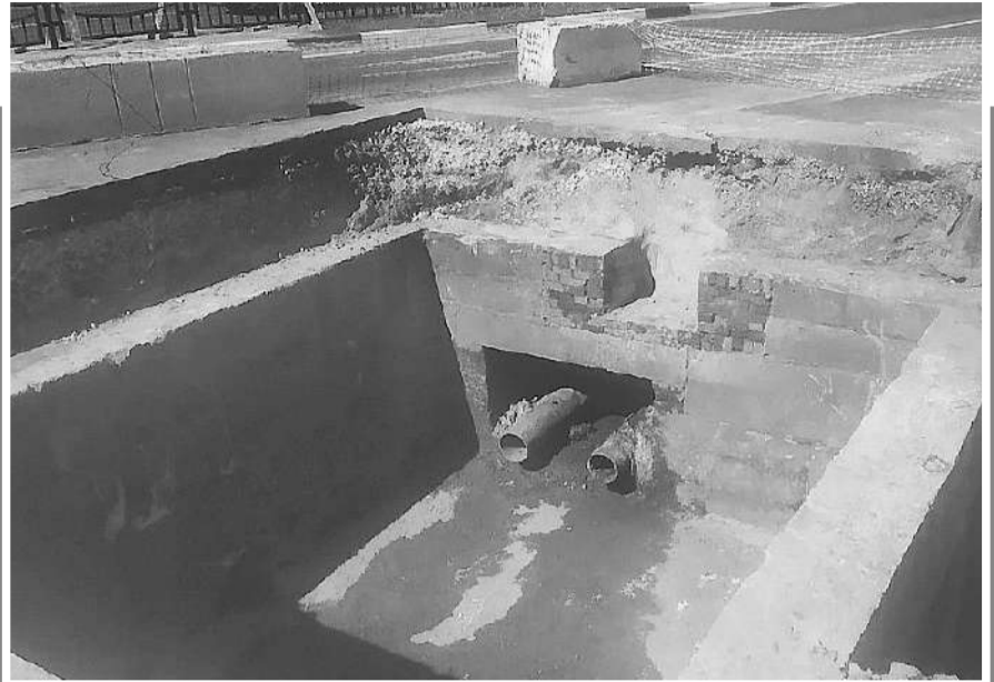
Коммунальщики во время планового капитального ремонта сетей вышли за пределы зеленой зоны и испортили отремонтированное полотно на улице Новоселов.
