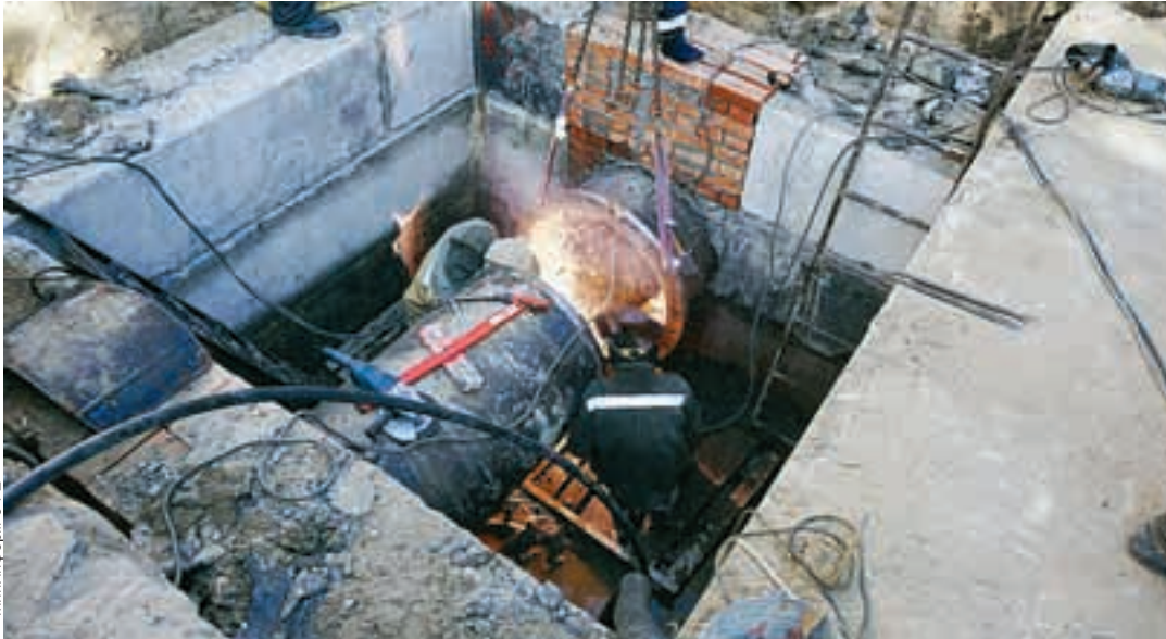
В этом году в областном центре планируется отремонтировать 27 км коммуникаций.
