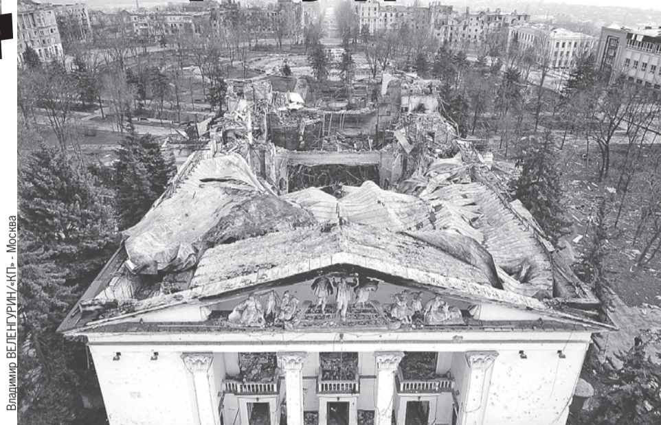
У Мариупольского драмтеатра после подрыва изнутри в 2022-м сложилась крыша, но стены устояли. Люди в подвале остались живы. Теперь Украина хочет повторить свой «трюк» - уже в детском саду или в больнице.
