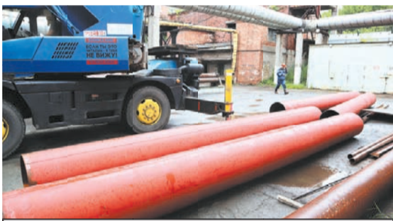
На всех котельных предприятиях пройдут плановые ремонты оборудования.
