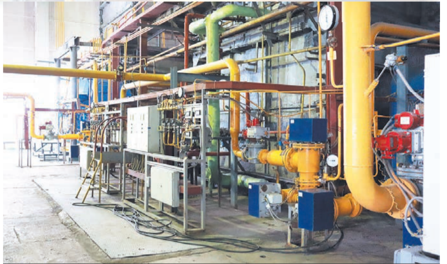
На объединенной котельной «Северная» прошли плановый ремонт уже четыре котла.
