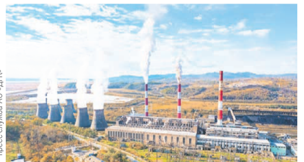
В 2024 году объем финансирования по программе повышения надежности Артемовской ТЭЦ составляет 572 млн руб.
