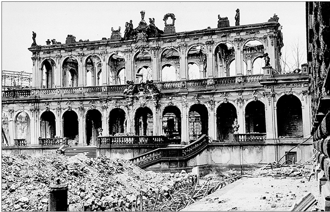
Разрушенное крыло музейного комплекса Цвингер.
