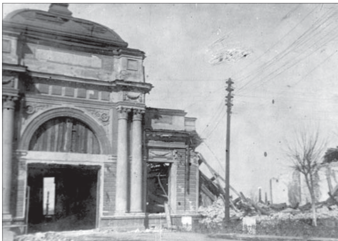
Взорванное здание железнодорожного вокзала.
