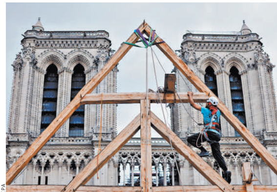
Плотники собрали один из главных элементов кровли Нотр-Дам, подняв его средневековой системой тросов и шкивов.
