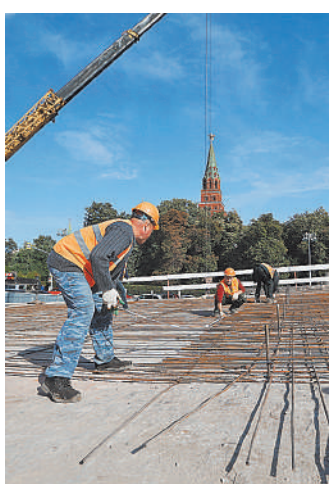
Большой Каменный мост капитально ремонтируют впервые почти за 80 лет его существования.
