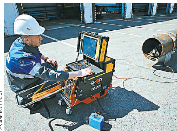
Работник помогает энергетикам найти скрытый дефект в трубе, предотвратив зимой аварию в теплосетях.
