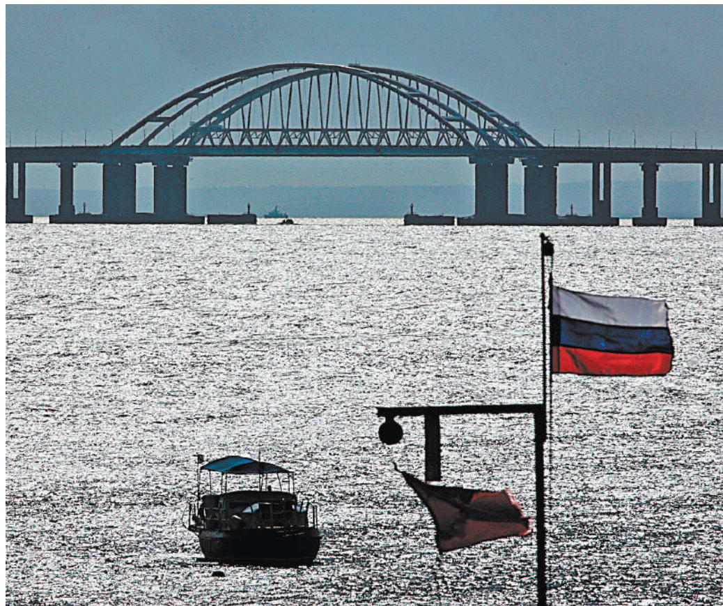
Судостроение в Керченском проливе не было нарушено. Начала активно работать и паромная переправа.
