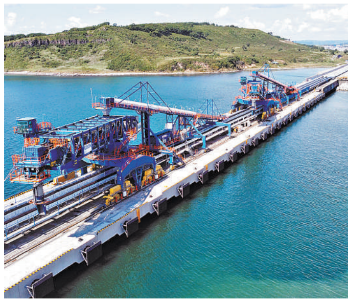
В Приморье завершается строительство портового комплекса «Суходол» для приемы, хранения и погрузки угля на морские суда.
