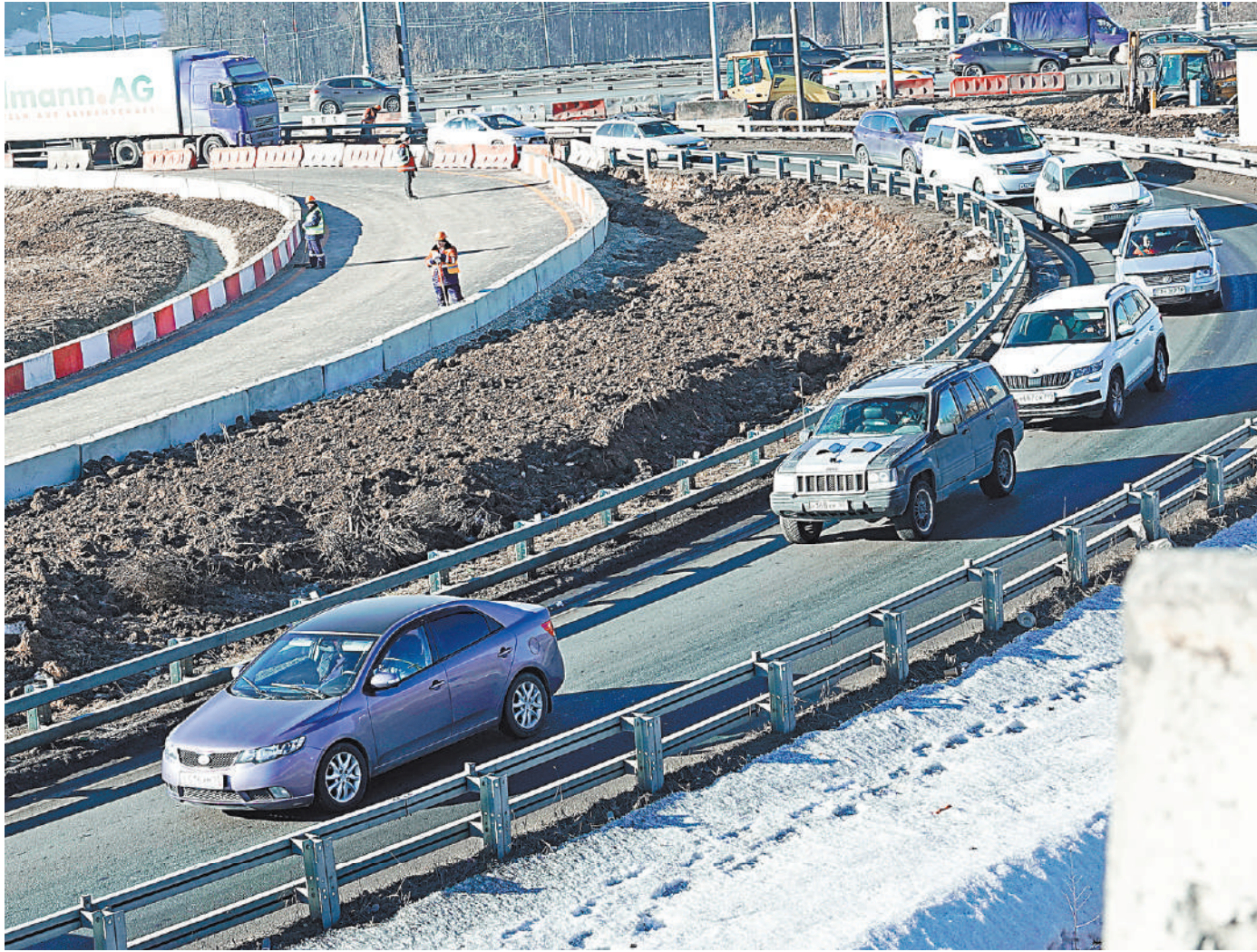
Вместо устаревшей развязки клеверного типа строители строят современные безопасные съезды с МКАД.
