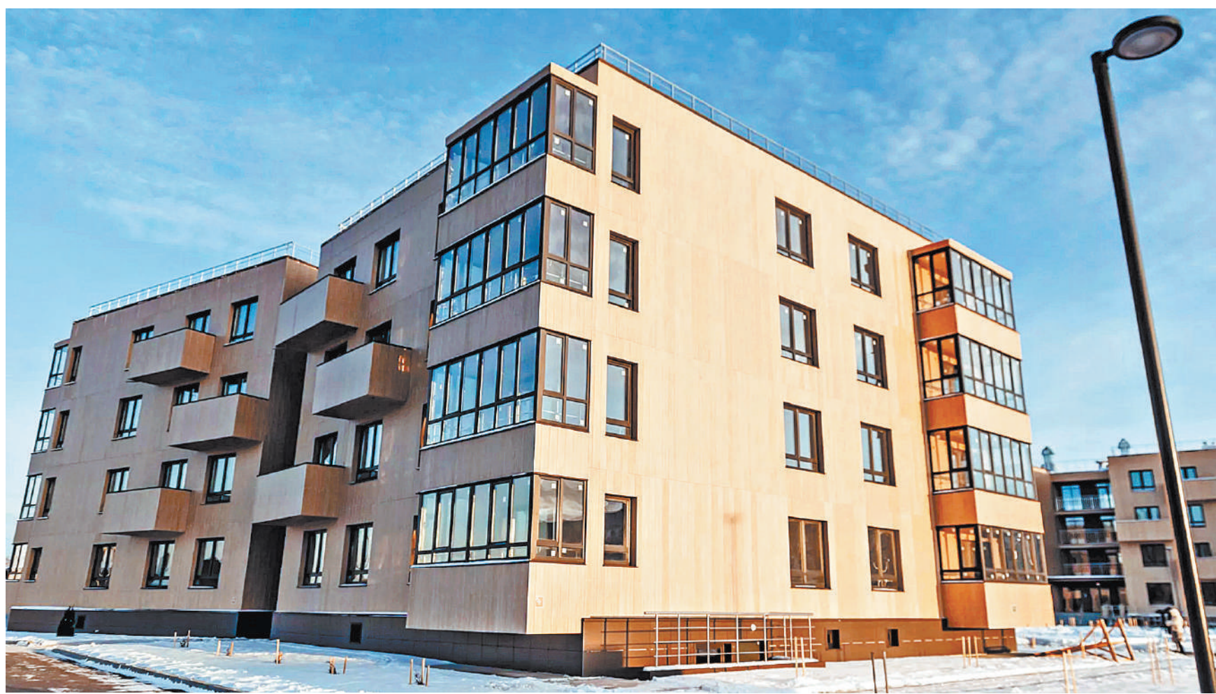
Здания из деревянных панелей могут простоять без капремонта около 50 лет.
