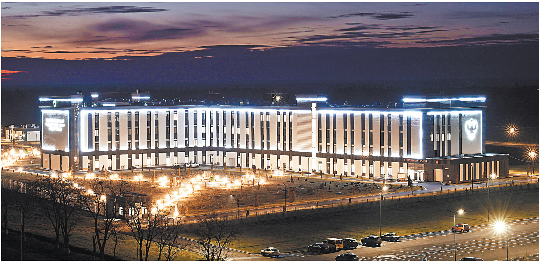
Новый медцентр военным строителям удалось построить за рекордные 10 месяцев. Местные жители не скрывают своего удивления — за 30 лет пребывания на Украине такого не случилось.
