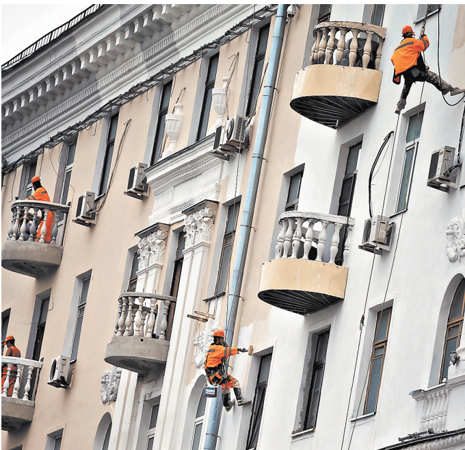
Лидером по числу поставленных на ремонт домов станет Центральный округ.
