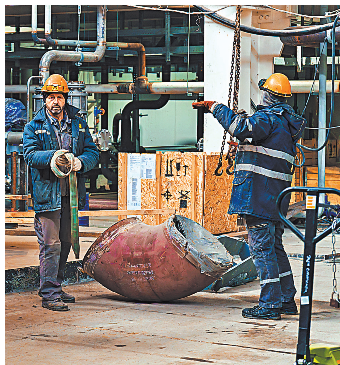
Пробный запуск котлов подтвердил: завод готов к пуску в эксплуатацию в ближайшие недели.
