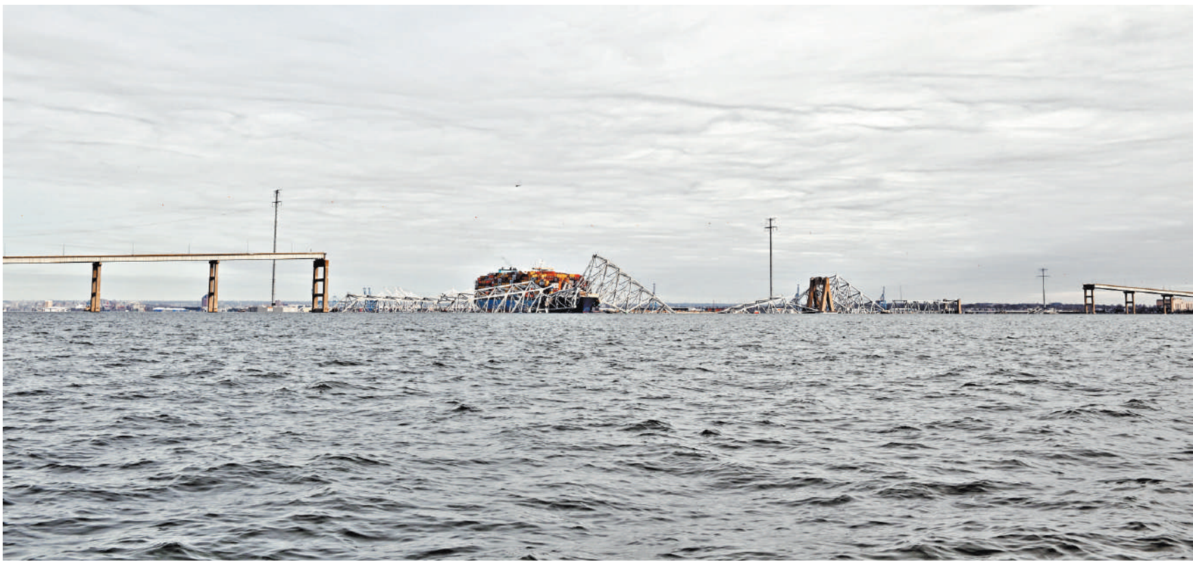
Контейнеровоз Dali, зафрахтованный грузоперевозчиком Maersk, врезался в автомобильный мост в американском Балтиморе (штат Мэриленд), что привело к обрушению конструкции. В воде оказались не менее семи автомобилей и рабочие, ремонтировавшие дорожное покрытие. Двух человек удалось вытащить из воды, спасатели вели поиски еще как минимум шестерых пострадавших. Мост протяженностью более 2,6 километра был построен в 1977 году и является частью шоссе I-695. Ежедневно по нему проезжали около 30 тысяч машин.
