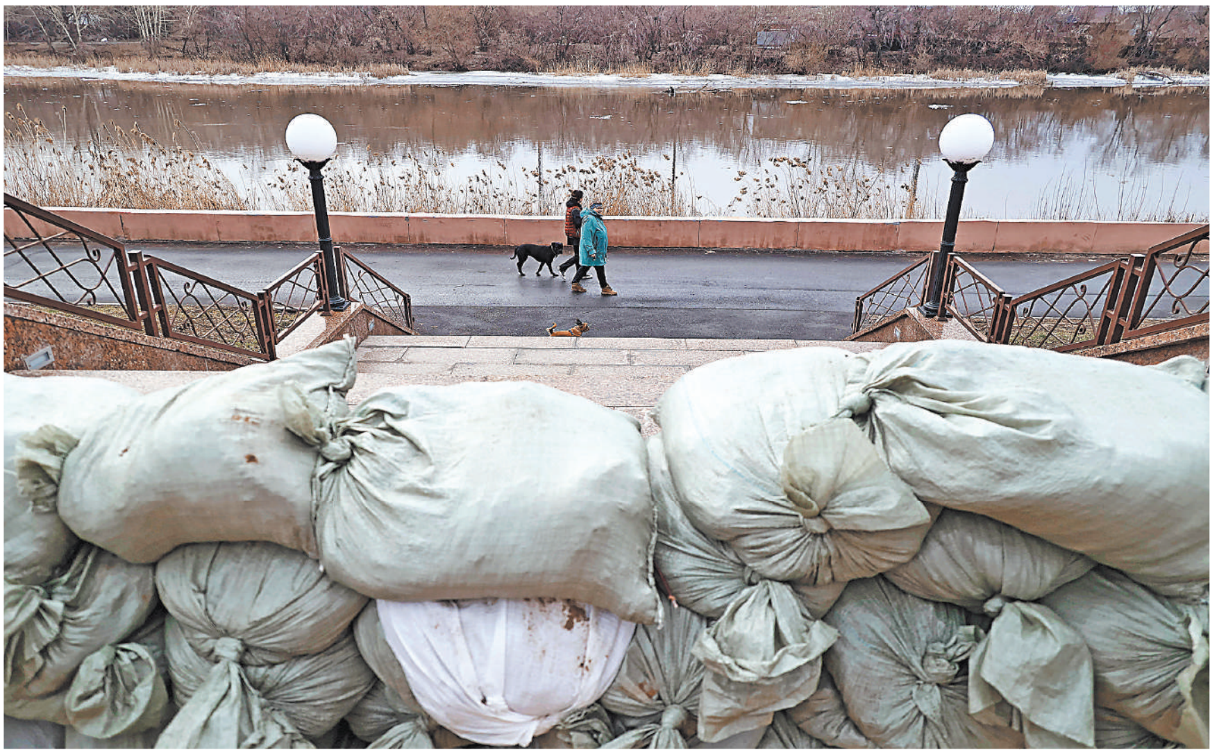
Набережная Тобола, как крепость: за несколько дней здесь вырос длинный и высокий брустер из мешков с песком и глиной.
