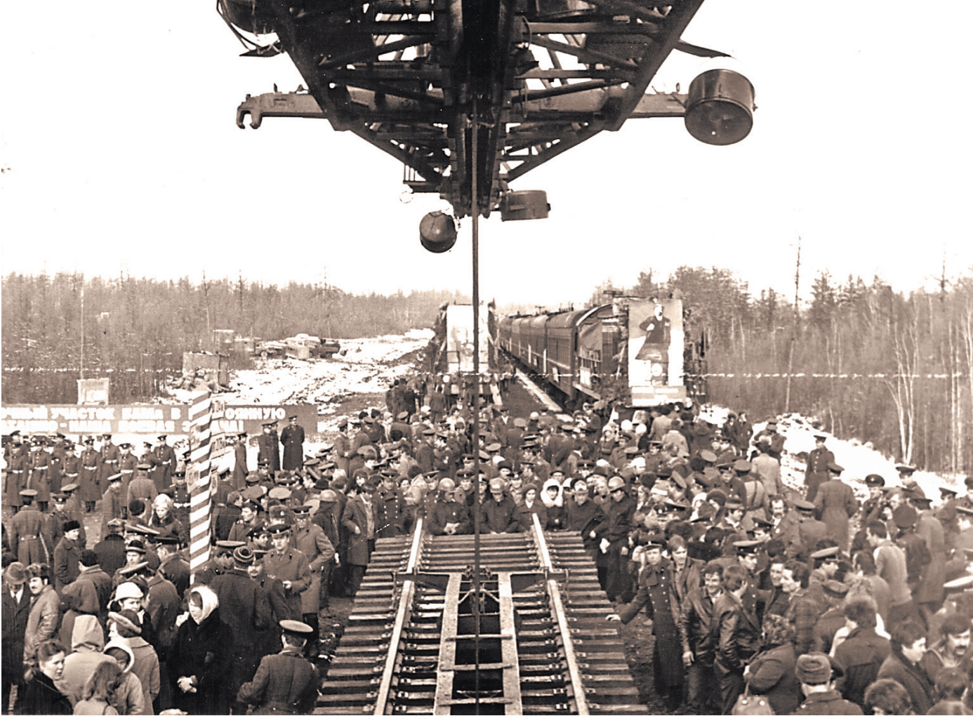
17 апреля 1984 года железнодорожные войска уложили «золотое» звено на разъезде имени героя Советского Союза Виктора Мирошниченко, сомкнув тем самым рельсы Центрального и Восточного участков. Досрочно завершено строительство Восточного участка БАМа.
