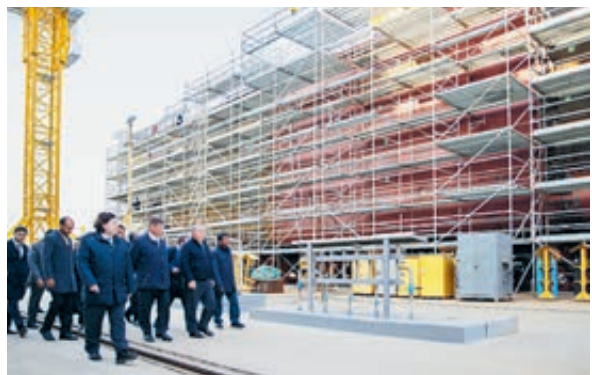
Индийская делегация осматривает ключевые производственные объекты ССК «Звезда», включая сухой док и достроечный стапель, где ведется сборка судна снабжения и танкера класса «Афрамекс».
