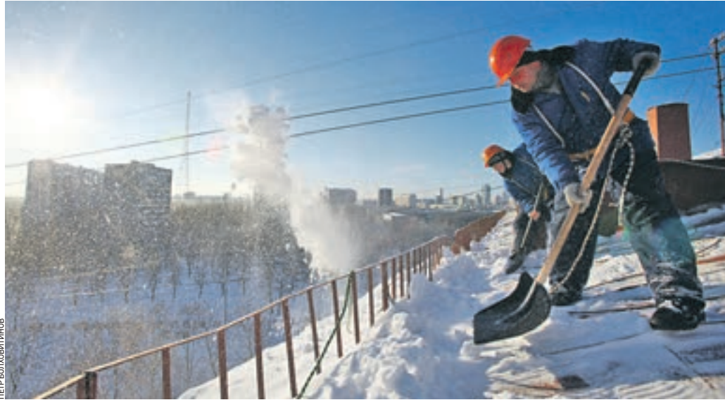
23 января 2014 года Коммунальщики очищают снег с крыши в районе Щукино. В этом феврале морозы и снегопады резко сменяются оттепелью, поэтому убирать сугробы нужно особенно быстро
