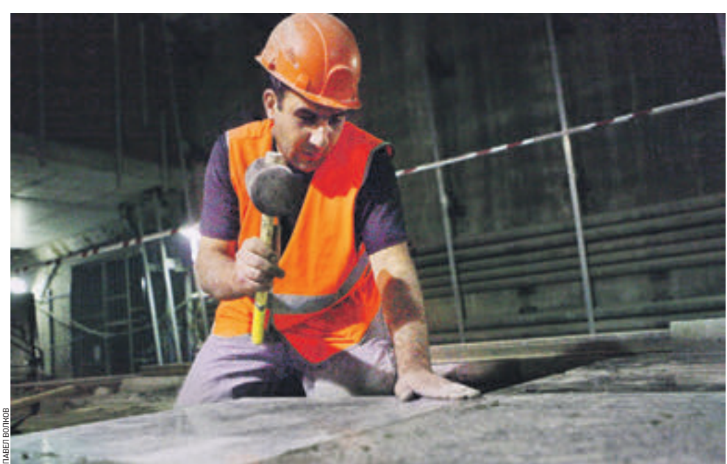
20 августа 2016 года 10:45 Рабочий Сергей Груднов укладывает каменные плиты на платформе строящейся станции «Минская» Калининско-Солнцевской линии метро
