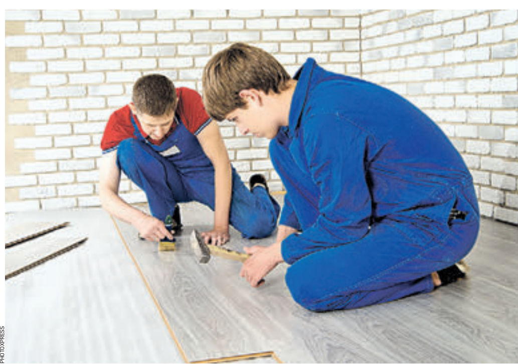
9 августа 2016 года. Отделочники укладывают ламинат в квартире дома на улице Нарвская. Как поясняют эксперты, если выбрать ламинат 32 или 33 класса прочности, он может эксплуатироваться десятки лет
