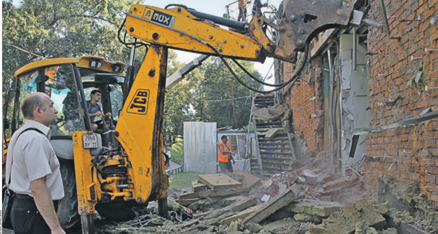
Вчера 10:40 Руководитель «Жилищника» Бутырского района Владимир Уланов (слева) следит за работой экскаватора с гидравлическим молотом, который ломает стену постройки над входом в станцию метро «Дмитровская». Полностью демонтаж самостроя завершится в выходные
