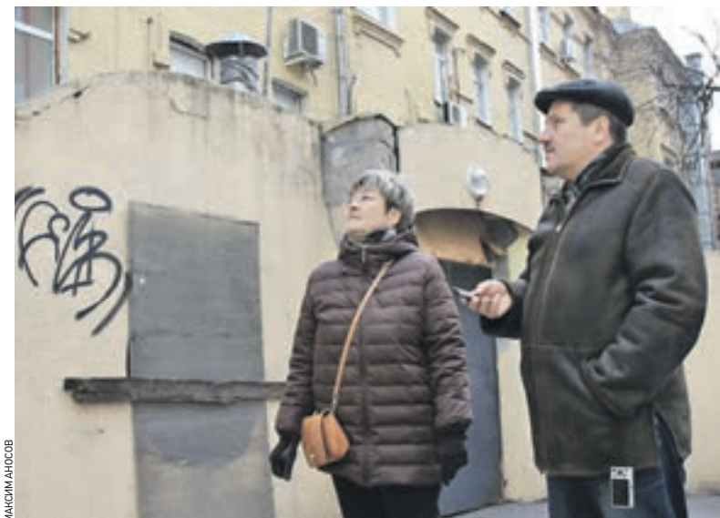
Вчера 14:40 Жительница района Татьяна Землезина показывает муниципальному депутату Андрею Вострикову незаконное строение
