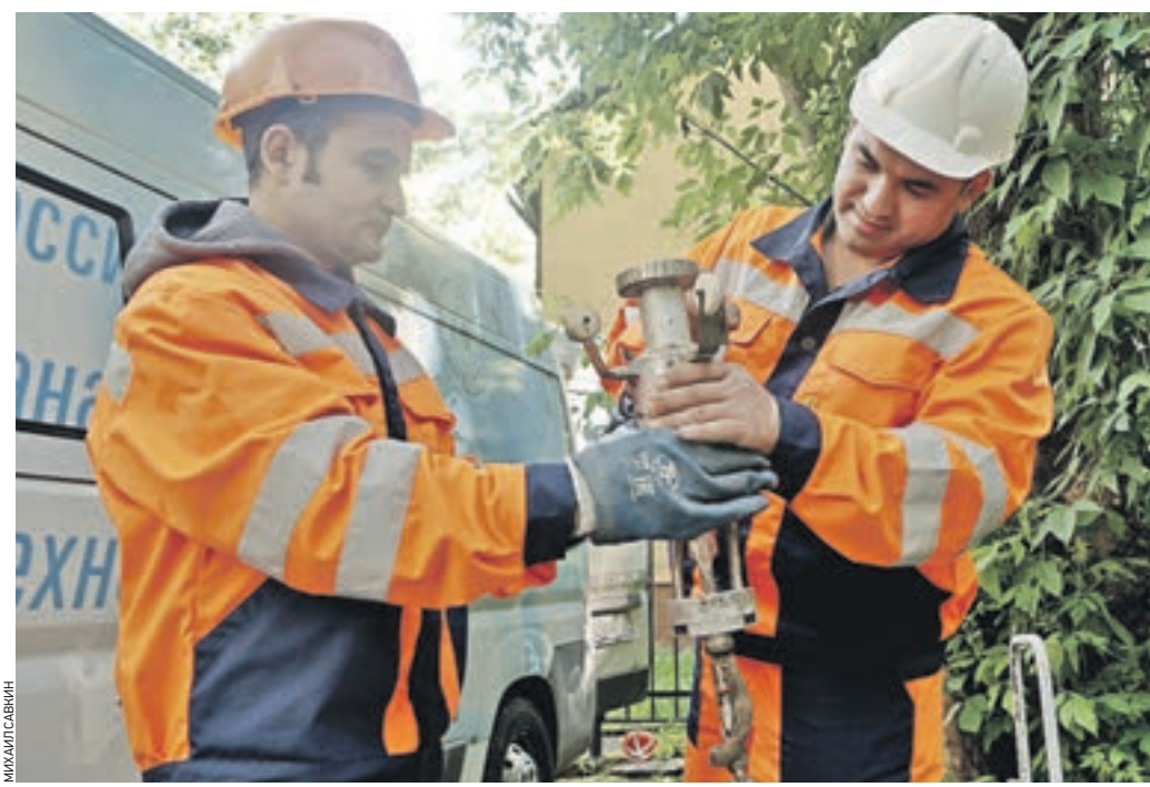
Вчера 11:00 Операторы санационной машины Аббас Алиев (слева) и Махмуд Муджол готовятся провести работы по ремонту водостока на Бойцовой улице
