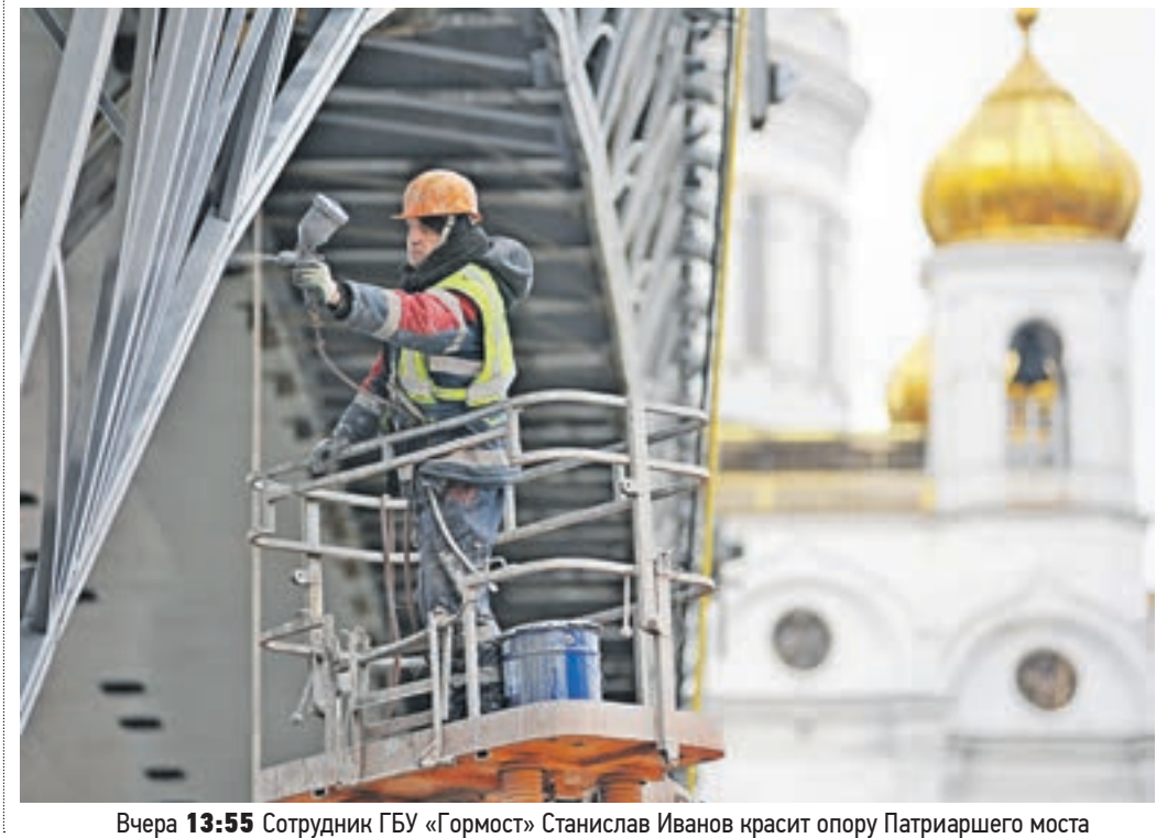
Вчера 13:55 Сотрудник ГБУ «Гормост» Станислав Иванов красит опору Патриаршего моста
