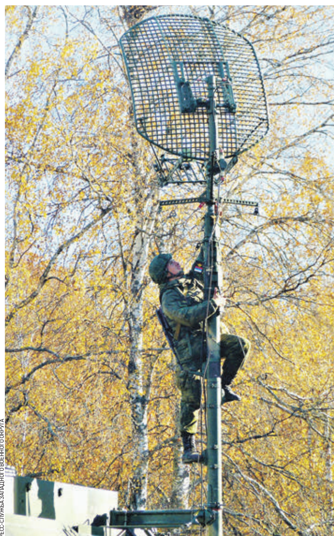
Вчера 14:10 Гвардии рядовой Андрей Ряполов монтирует антенну в ходе развертывания узла связи
