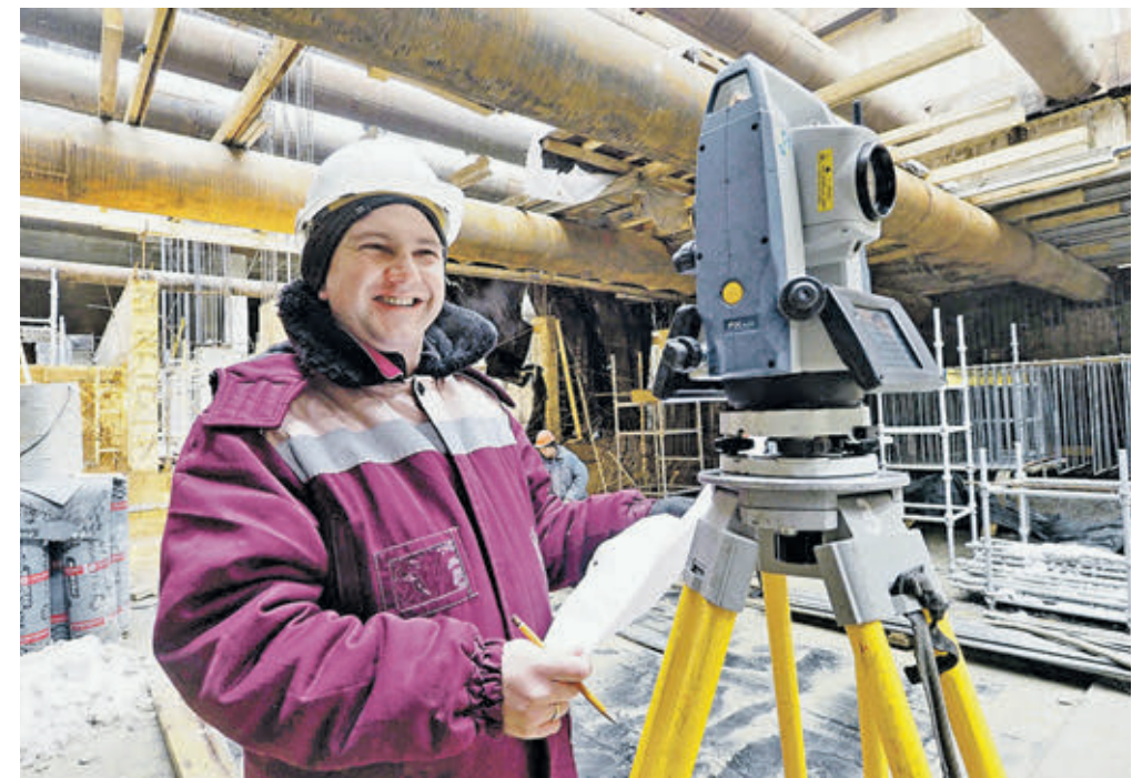
Вчера 11:56 Маркшейдер-метростроевец Денис Ловчан проводит пространственно-геометрическое исследование на строящейся станции метро «Лефортово»
