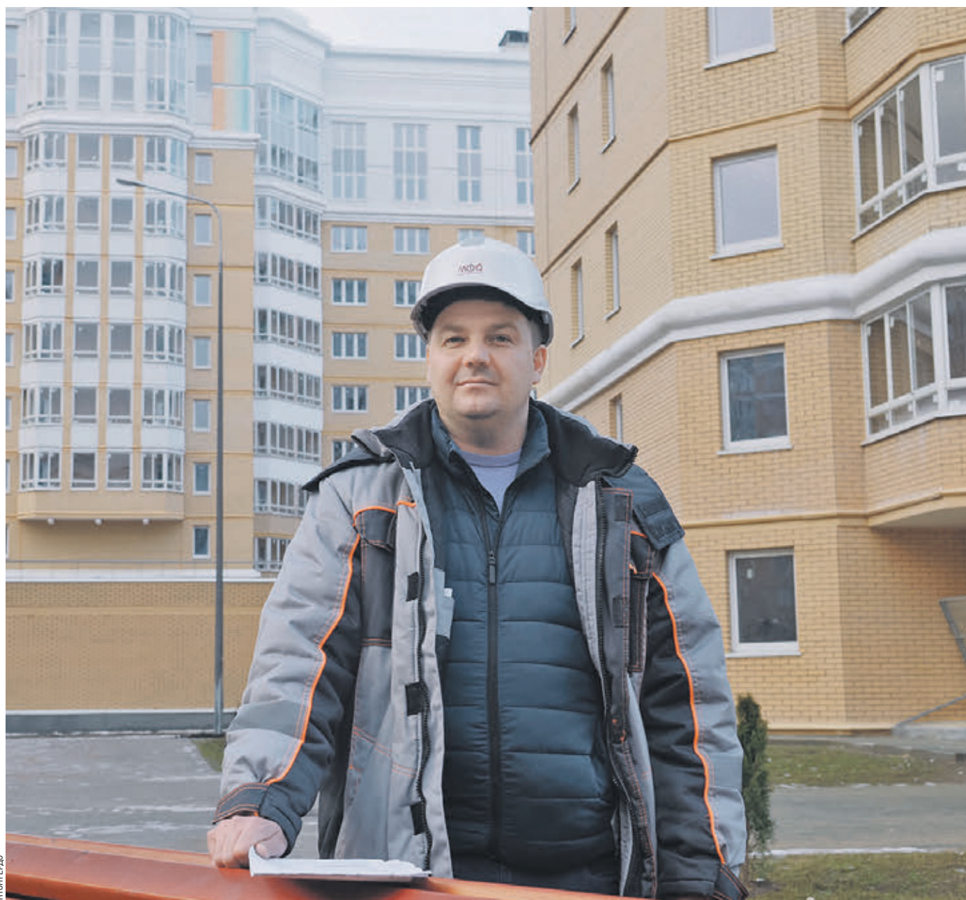
17 января 15:00 Заместитель директора по строительству проблемного объекта на юге Москвы Александр Табачков на фоне многоквартирного дома, который скоро сдадут в эксплуатацию
