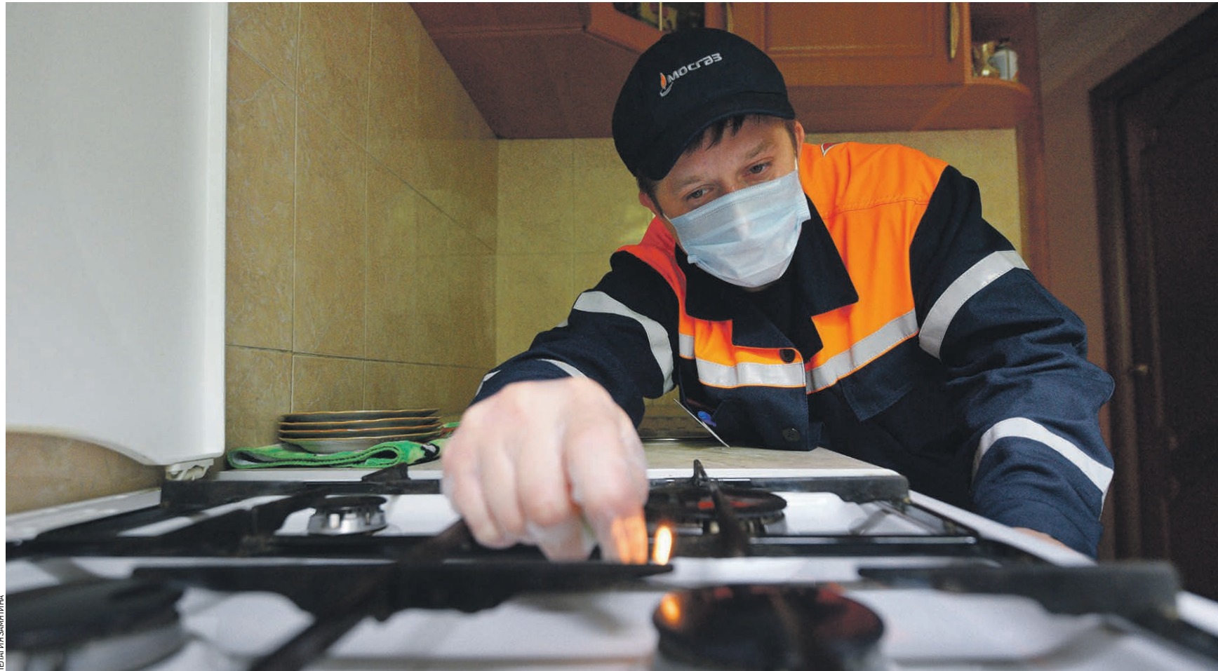
Вчера 10:37 Слесарь Мосгаза Михаил Булычев проводит плановое техническое обслуживание газового оборудования в квартире жилого дома на Сиреневом бульваре. Газовая плита работает правильно и в дополнительной настройке не нуждается
