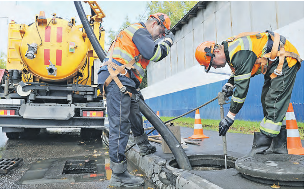
Вчера 14:25 Специалисты Мосводостока Александр Коноков (слева) и Юрий Черницын очищают водоприемный колодез
