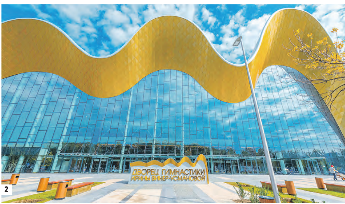
28 октября 2020 года. Строители метро на выходе проходческого щита «Виктория» на Большой кольцевой линии (1) 19 июня 2019 года. Дворец гимнастики Ирины Винер-Усмановой возвели по индивидуальному проекту с помощью BIM-технологий. Его символом стала кровля — она напоминает развевающуюся гимнастическую ленту (2)
