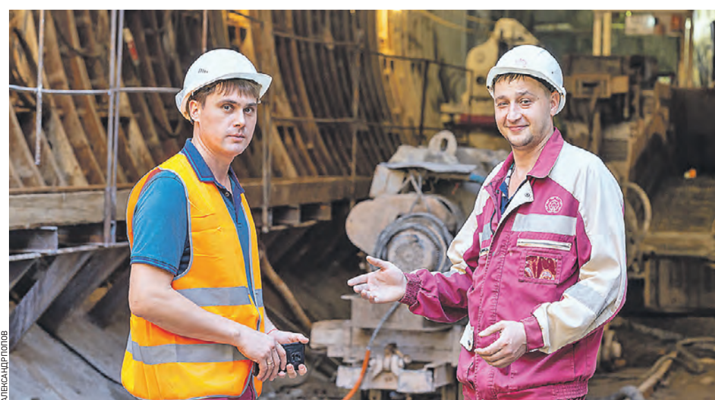
16 июля 08:39 И.о. начальника участка «СМУ-1» Алексей Григорьев (справа) и его коллега Роман Киринов во время строительства пункта пересадки на станции «Авиамоторная»
